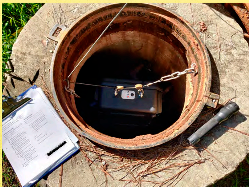
最初の顧客であるノースカロライナ州ケーリーでのマンホール・サンプリングの様子。提供写真
